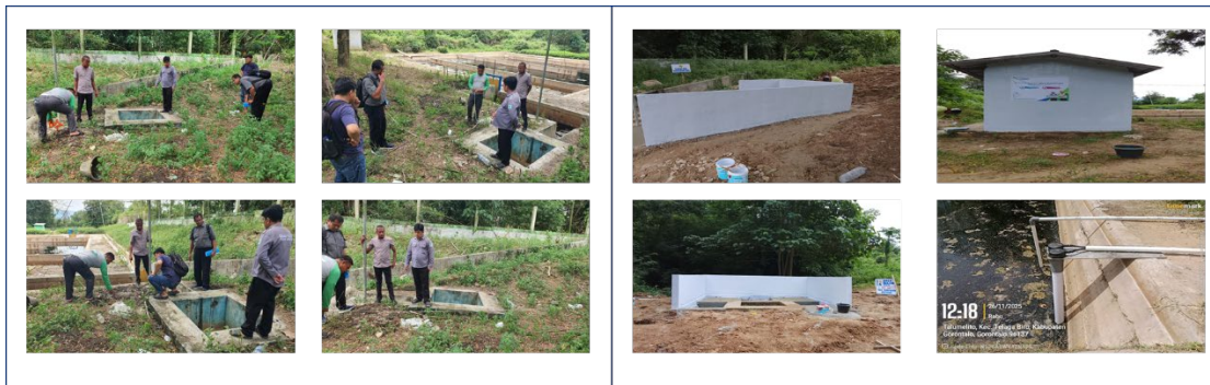
図 5-17 オーバーフロー対策工事实施前（左）と実施後（右）
