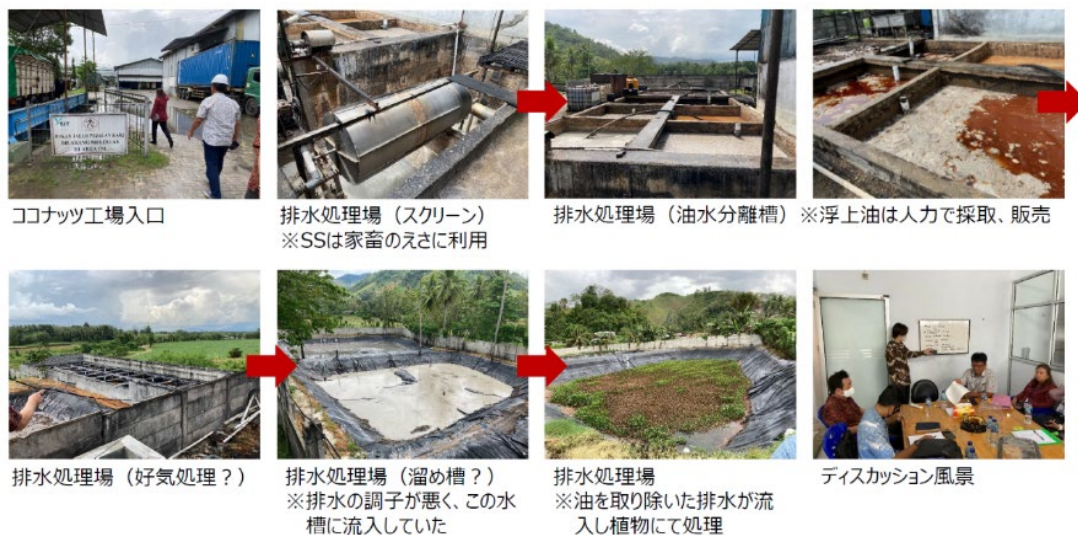
図 3-17 2022 年 11 月時点の PT. Trijaya Tangguh における排水処理フロー ((株)愛研化工機作成)
