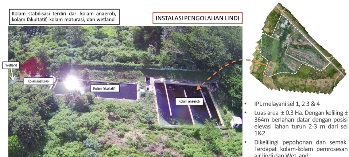
図 5-6 最終処分場浸出水処理設備概要図
