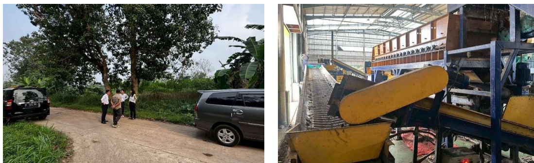
図 3.3.2.1. ボゴール県ルンピンの RDF 施設建設予定地（左）とブカシ市の RDF 施設 TPST Kertamukti（右）（出所：調査団が撮影）
