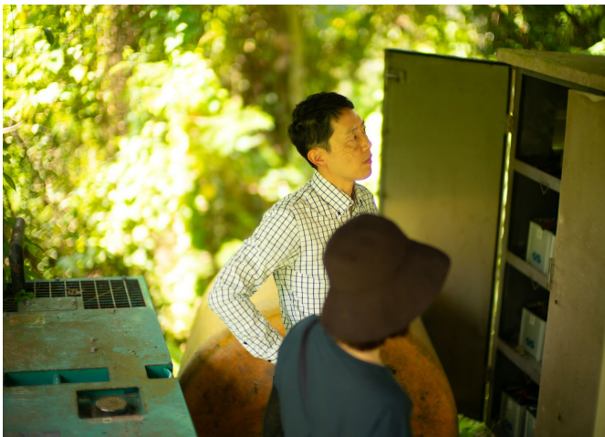
図 3-42 故障状況の調査の様子
