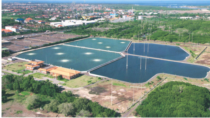
図 3-25 IPAL Suwung の曝気池（左）と安定化池（右）
