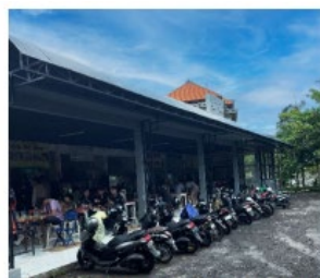
ひさしに設置したフレキシブル太陽光パネル
