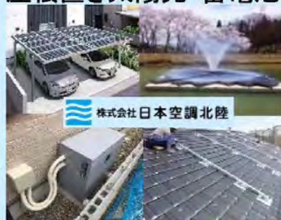
屋根置き太陽光+蓄電池
