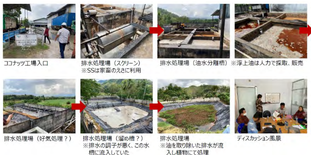
図 28 2022 年 11 月時点の PT. Trijaya Tangguh における排水処理フロー ((株)愛研化工機作成)
