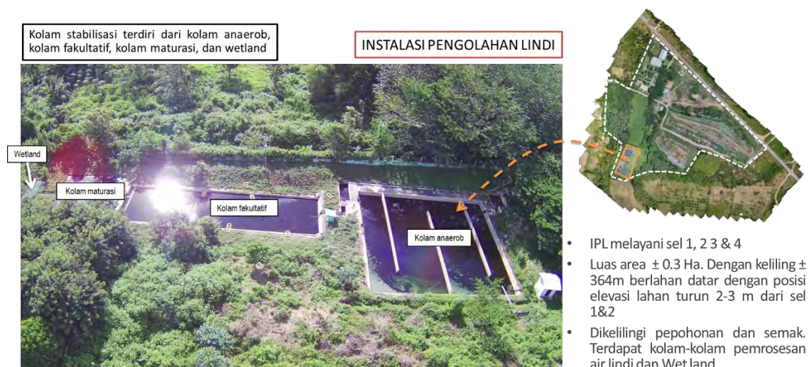
図 56 最終処分場浸出水処理設備概要図
