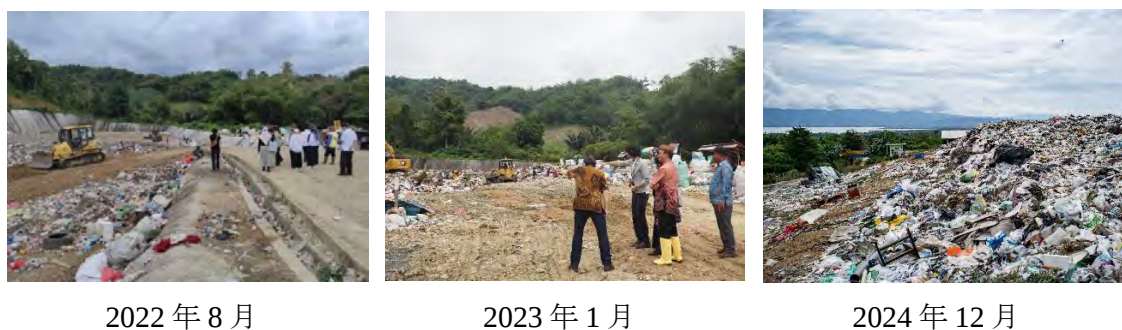
図 55 最終処分場の様子
