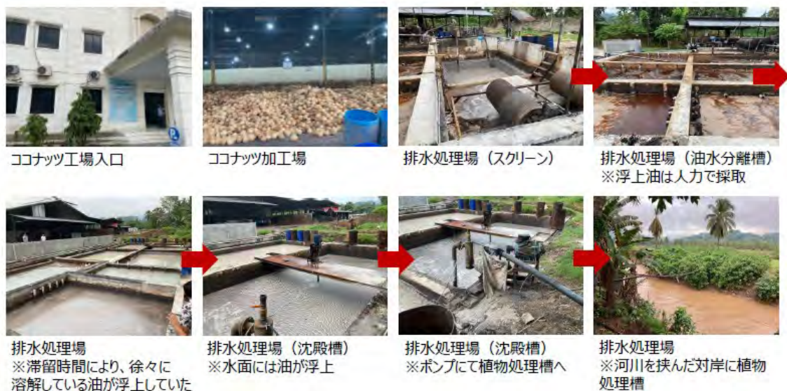
図 17 PT. Royal Coconuts における排水処理フロー（(株)愛研化工機作成）
