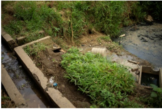
図 3-15 食堂における排水処理（排水路（左）とため池（右））
