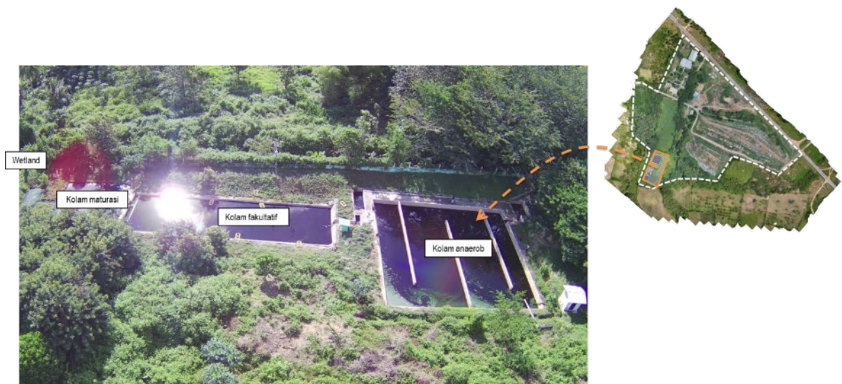
図 3-40 既存の浸出水処理設備
