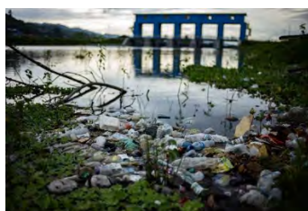
河川を介してゴミなどの流入も多い
