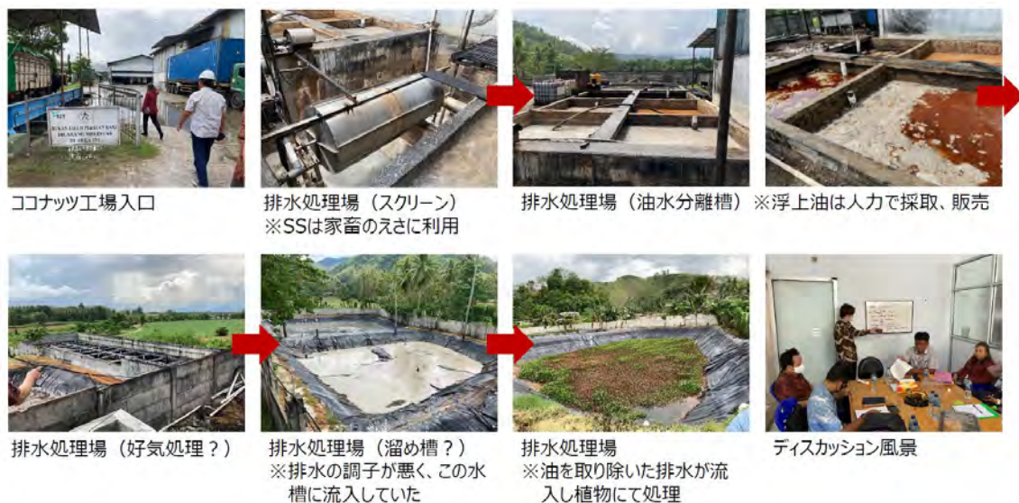
図 3-2 2 現在の PT. Trijaya TANGGUH における排水処理フロー（株式会社愛研化工機作成）
