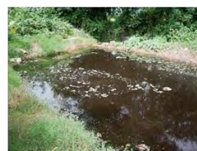
本来ため池の底のフィルターでろ過し地面に浸透させていたが、現在はフィルターが詰まり、河川へ放流されている状態
