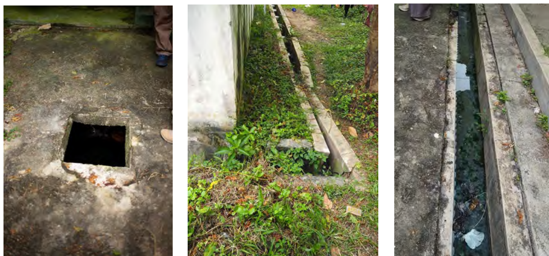
図 3-1 1 女子寮における排水処理（し尿処理（Septic Tank）（左）と生活排水路（右））
