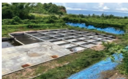
排水処理場（全体）
