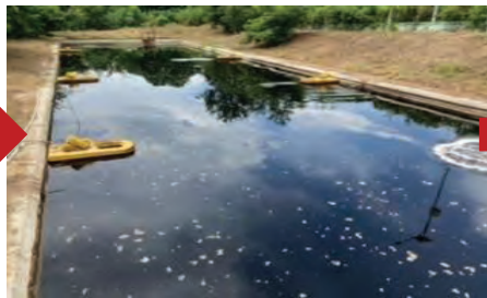
排水処理場（表面曝気槽）
