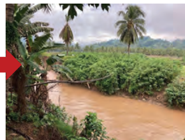
排水処理場 ※河川を挟んだ対岸に植物処理槽
