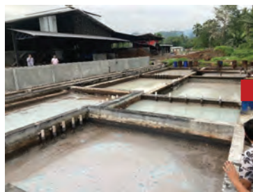
排水処理場 ※滞留時間により、徐々に溶解している油が浮上していた
