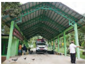
▲トラックスケール
