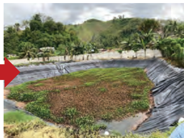
排水処理場 ※油を取り除いた排水が流 入し植物にて処理
