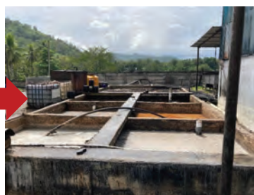
排水処理場（油水分離槽）※浮上油は人力で採取、販売
