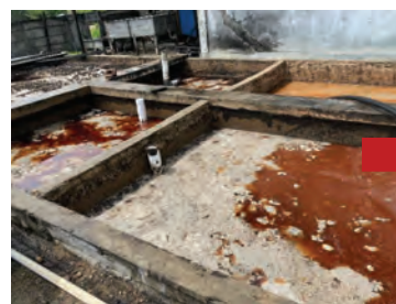
排水処理場（油水分離槽）※浮上油は人力で採取、販売
