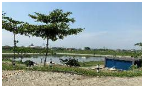
ポンプ場調整池
