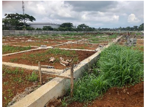
新工場建設現場
