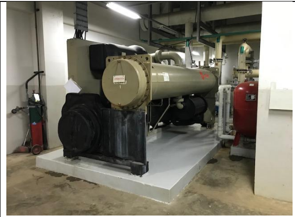
既設チラーの調査
