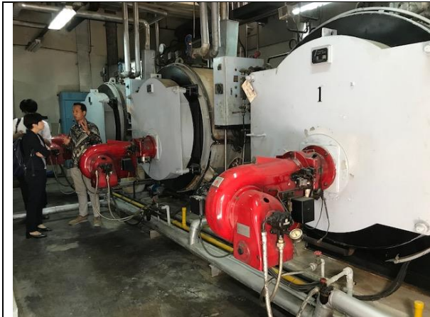
既設ボイラの調査
