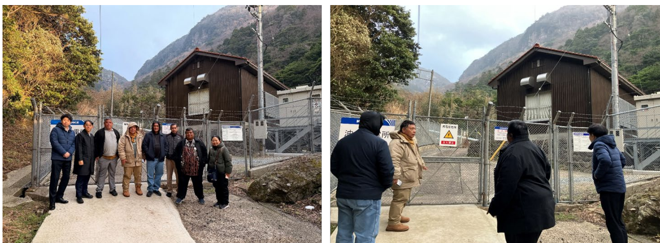
図 2-24 油井水力発電所（外からの見学のみ）
