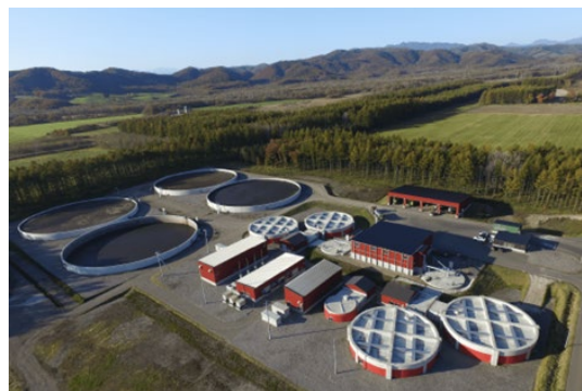
図 3-8 バイオガスプラントの全景
