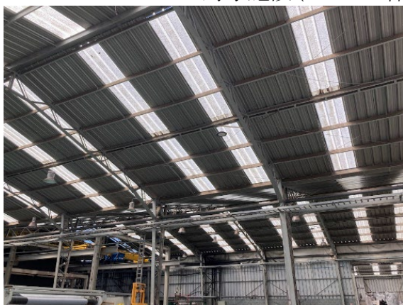
ビニール製造工場の PV 導入予定屋根 出典：日本工営
