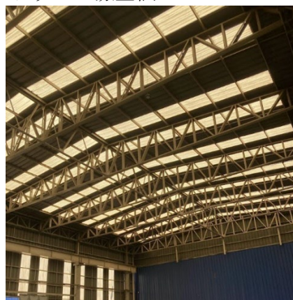
浮遊体製造工場の PV 導入予定屋根
