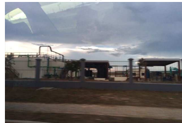
給水処理施設
