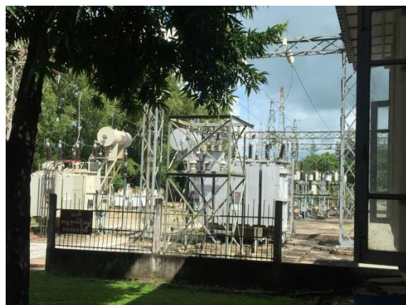
変電施設（パティン市内）
