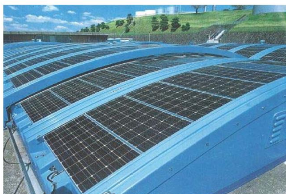
図 3-8 覆蓋太陽光発電システム
