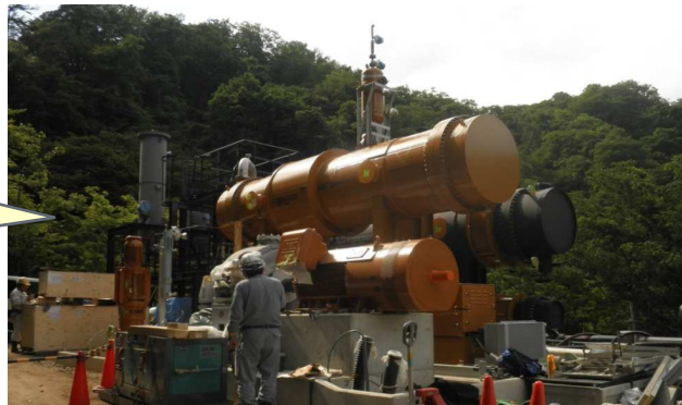
設置工事中の バイナリー発電機
