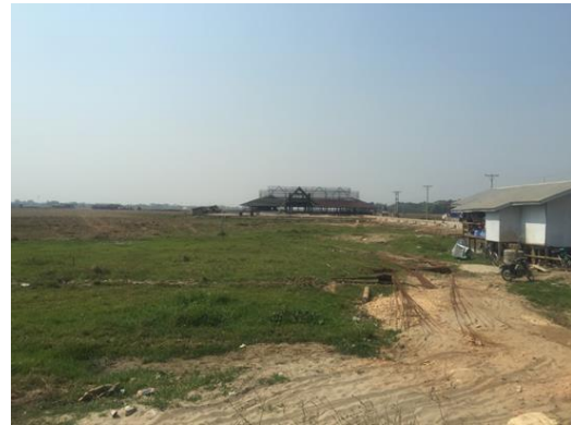
パティン市の新規工業団地（建設中）
