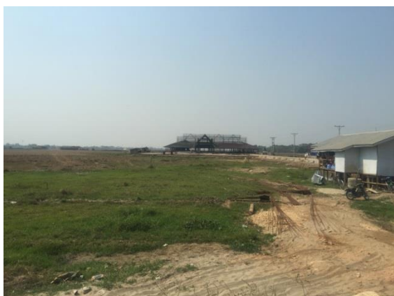
工業団地の管理事務所（建設中）
