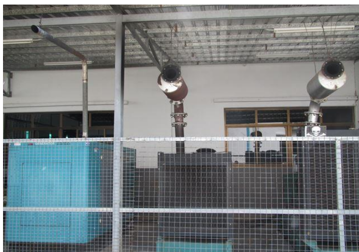
図 2-8 停電用発電機
