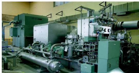
蒸気タービン発電機
