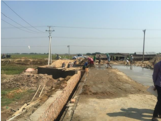
工業団地予定地内での道路工事の様様
