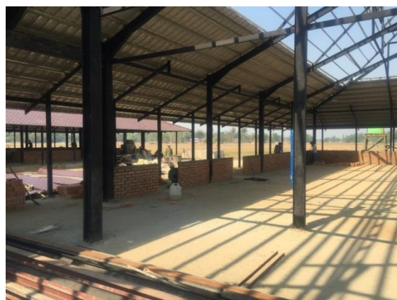
工業団地の管理事務所（建設中）
