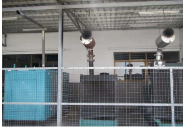
停電用発電機
