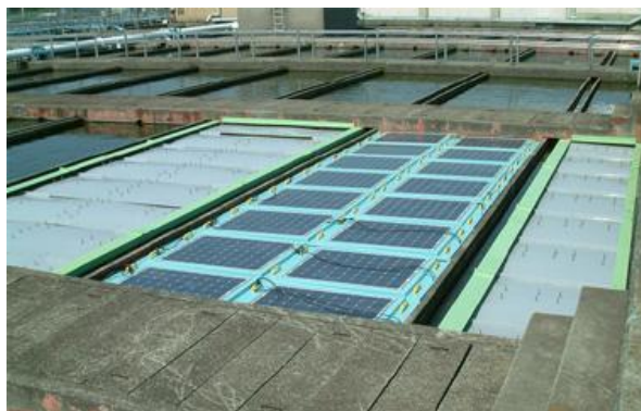
図 3-9 フロート式覆蓋太陽光発電システム
