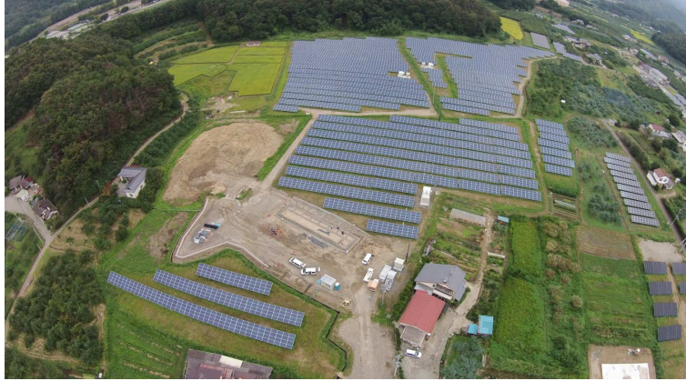
市内にある大規模太陽光発電設備 (写真提供：株式会社アポロガス)
