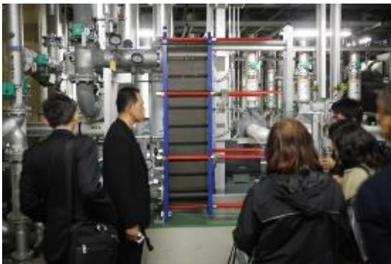
下水熱利用のための熱交換器
