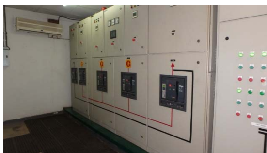
図 3-9 : 系統/発電機切替盤
