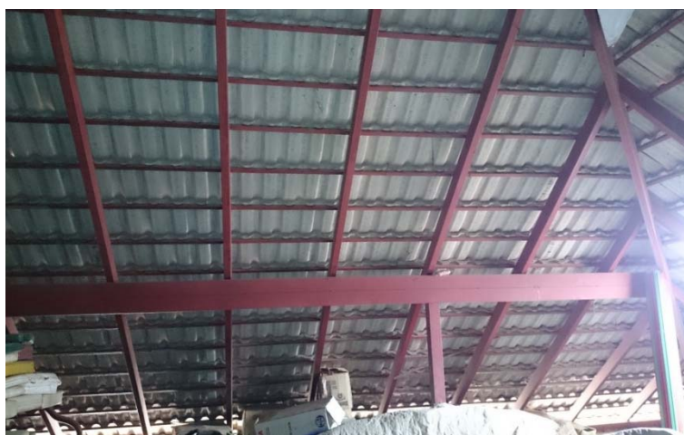
図 3-3 : A-Hotel の屋根裏
