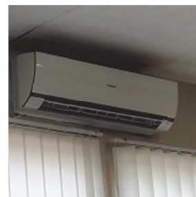
写真 3-3：工場オフィスに設置された空調の例
