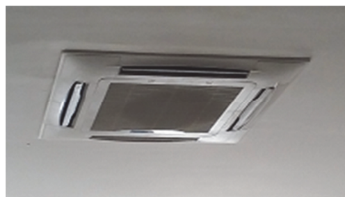
写真 3-1 : A ホテルに設置された空調の例
