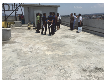
写真 3-2 : A ホテル屋上の様子
