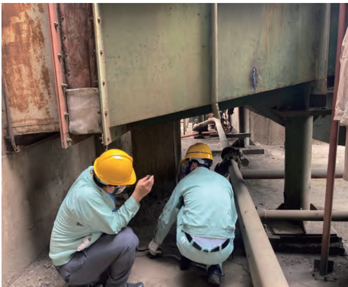
Khảo sát hiện trường (kiểm tra ống dẫn quạt hiện có)
