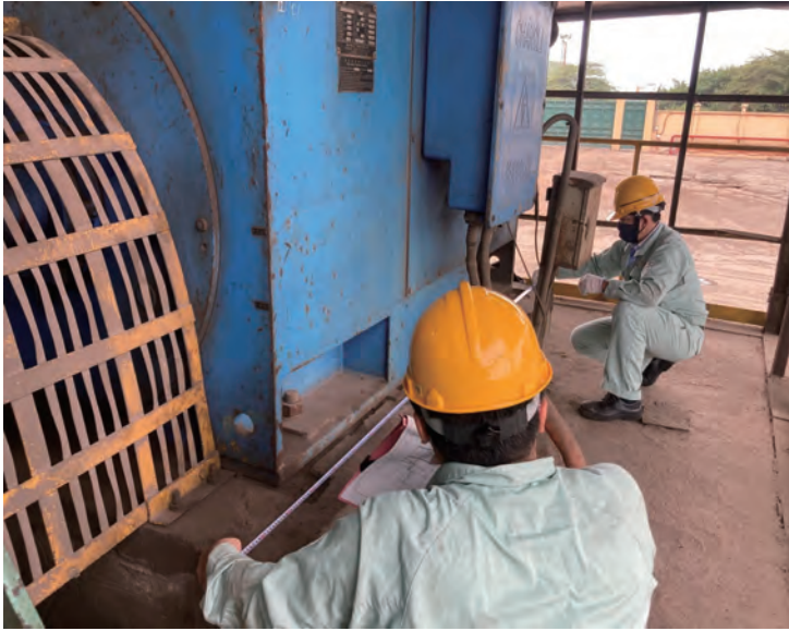
Khảo sát hiện trường (phần động cơ)
