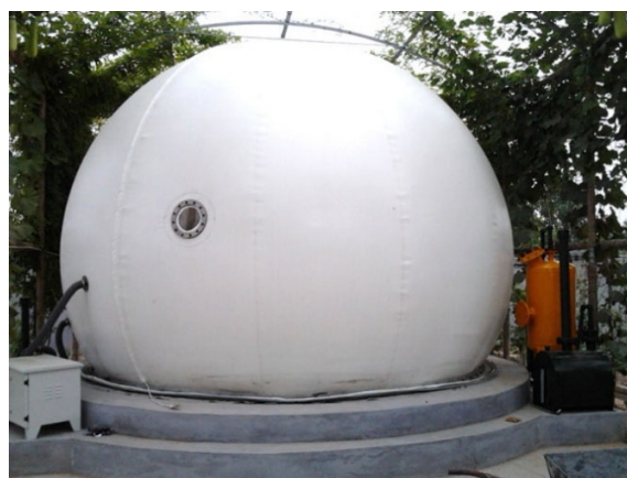
Photo 4.2.2 Biogas holder※
