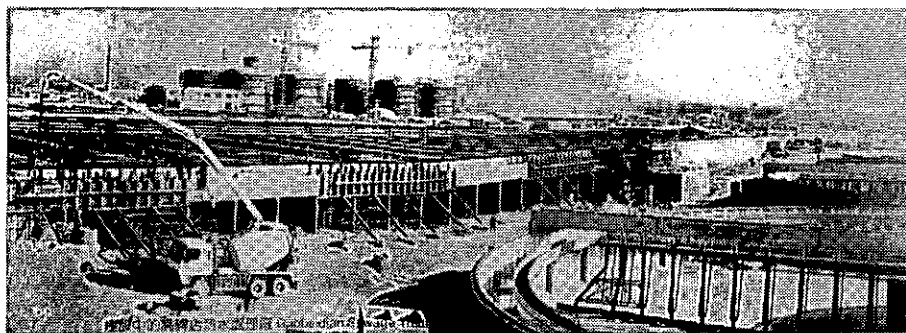
写真 11.1 建設中の高碑店汚水処理廠一期
