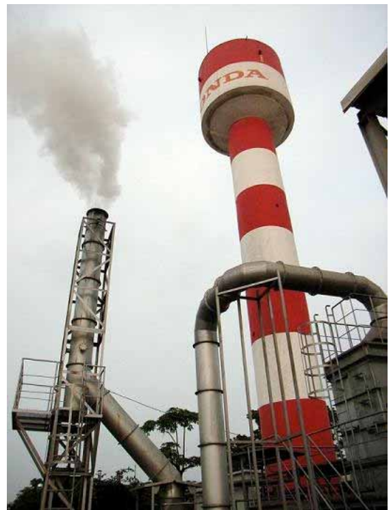
改修後の焼却炉(水蒸気のみ発生)
