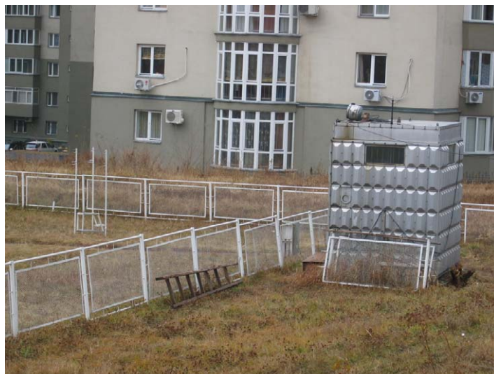
大気汚染観測ポスト （アルマティ市内）
