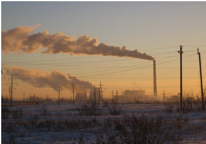
アスタナ市郊外の発電所
