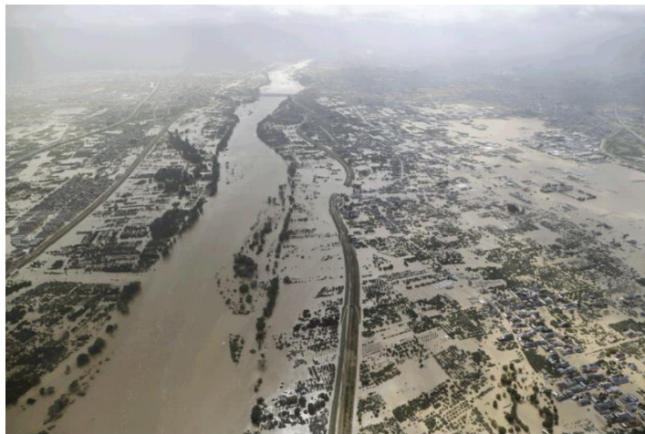
▲令和元年東日本台風による被害の様子
