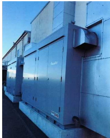
空気冷媒冷凍機ユニット
