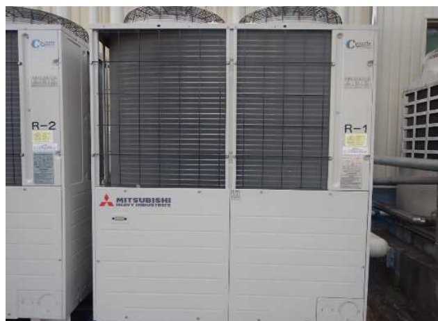
冷凍機ユニット
