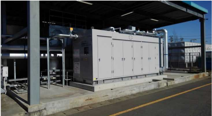
NH 3 冷媒冷凍機ユニット
