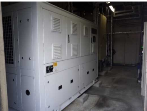
冷凍機ユニット
