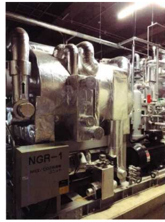
NH 3 /CO 2 冷媒冷凍機ユニット
