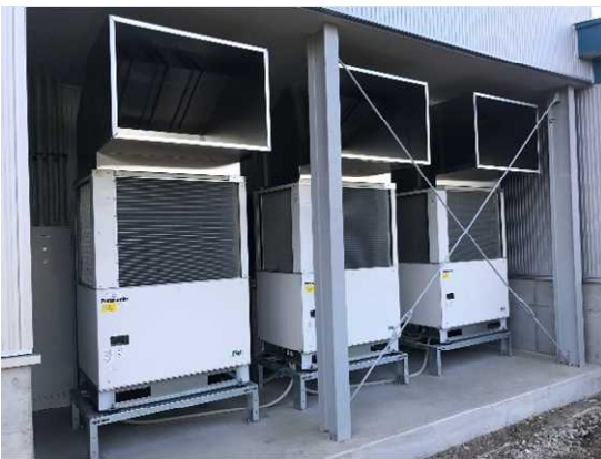
冷凍機ユニット
