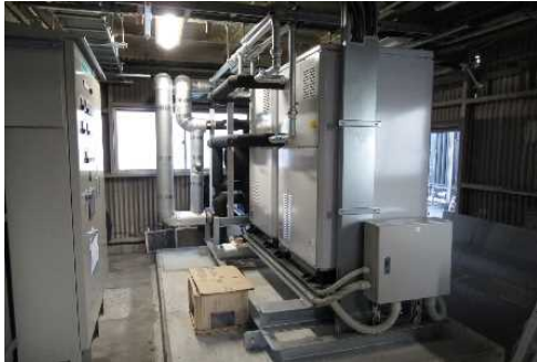
冷凍機ユニット
