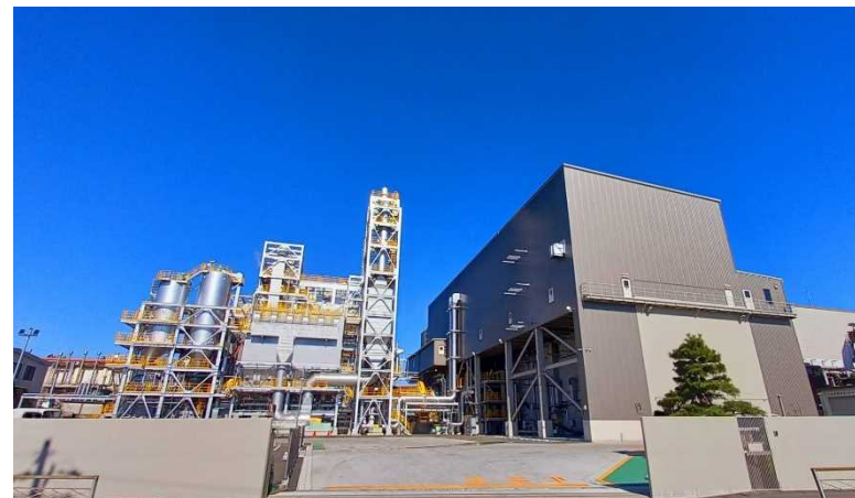
対象施設の外観（伏見環境保全センター）
