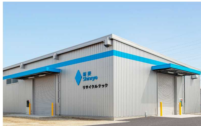
対象施設の外観
