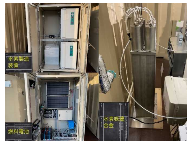
水素製造装置、 燃料電池、 水素吸蔵合金
