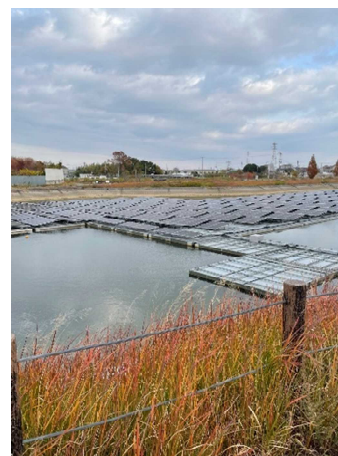
太陽光発電設備
