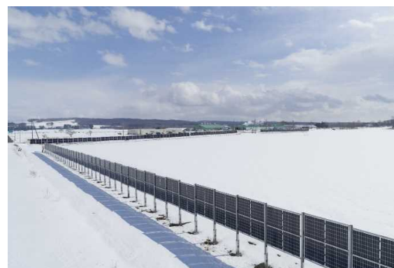
垂直設置型太陽光発電設備
