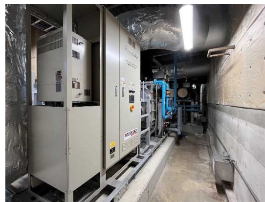
空気冷媒冷凍機（外観）
