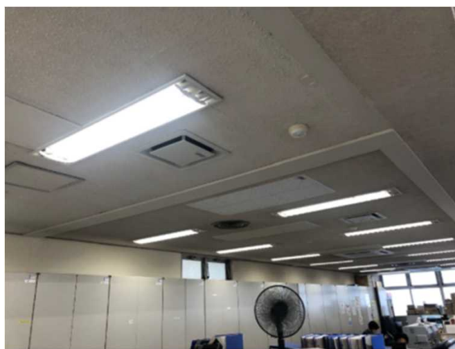
高機能換気設備（全熱交換器）
