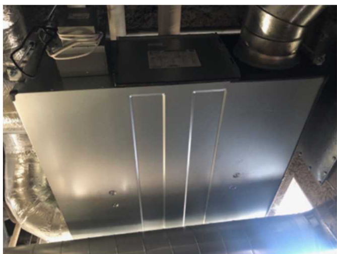
高機能換気設備（全熱交換器）
