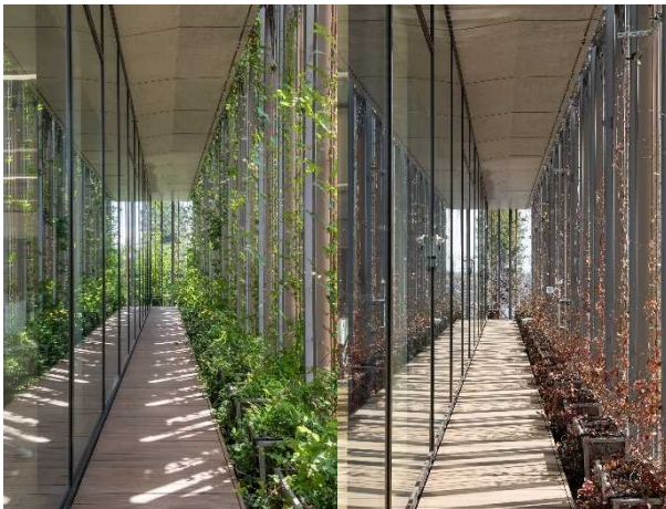
壁面緑化ユニット（左：夏期、右：冬期）
