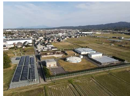
竹矢ポンプ場
