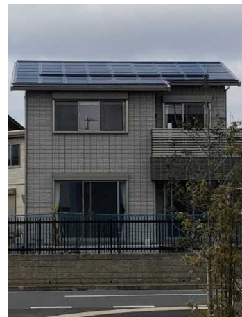
PV集熱パネル
