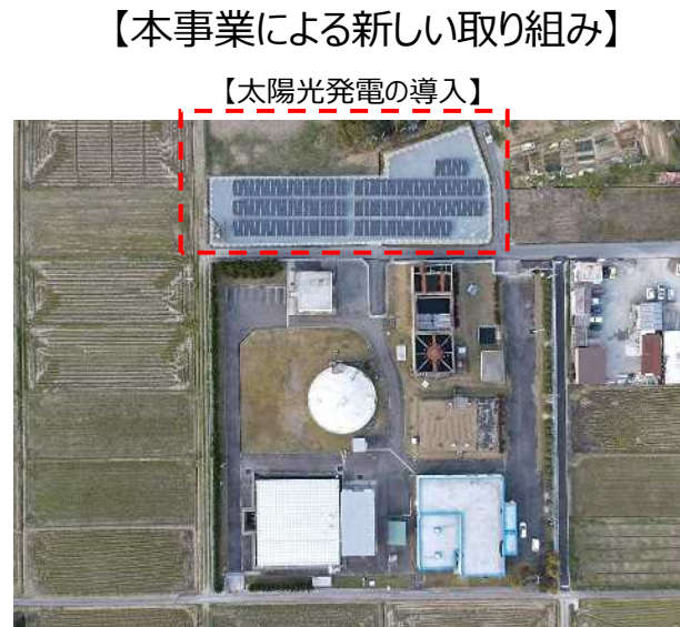
写真：竹矢ポンプ場(真上)
