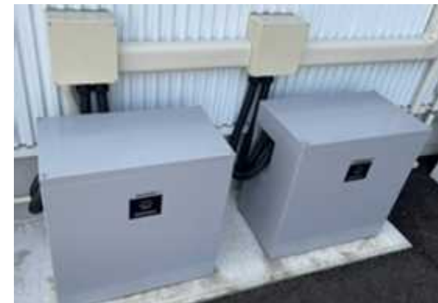
災害時を想定して導入した蓄電池
