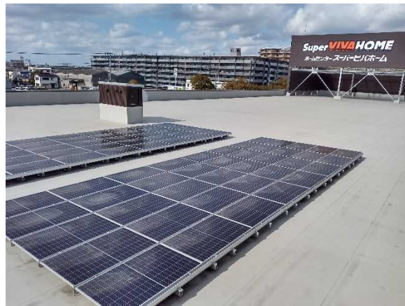
太陽光発電設備
