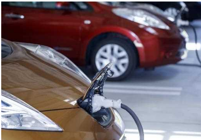
直流のままEVに充電できるV2H (補助対象外設備として導入)
