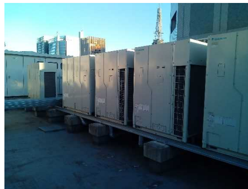
高効率空調 室外機
