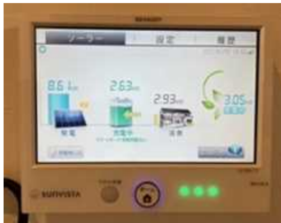
BEMSモニタで発電状態、放電状態、蓄電状態、CO 2 削減量を 確認しながら、運用改善の検討を実施
