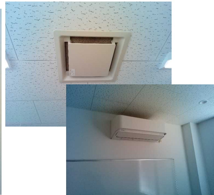
全熱交換器と高効率空調機
