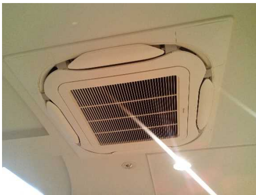
高効率空調 室内機
