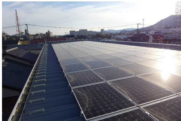
太陽光発電設備
