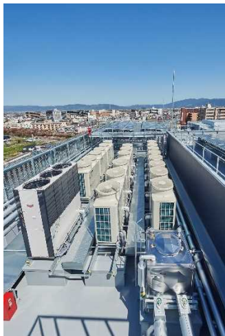
室外機（GHP、EHP）、太陽光発電
