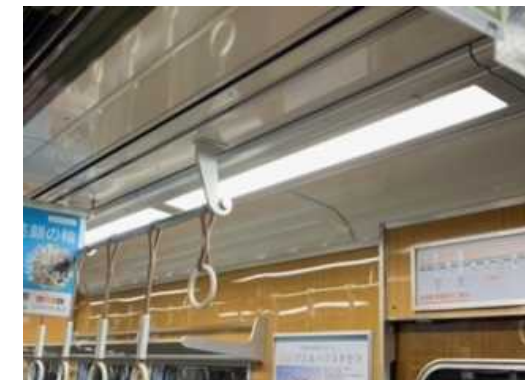
LED照明装置
