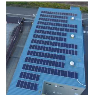
太陽光発電設備
