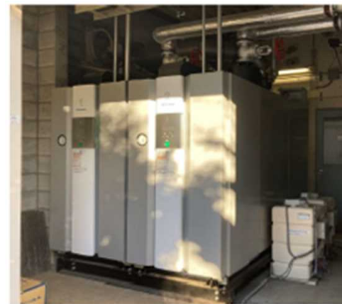
ガス焼き高効率ボイラ (設備本体)
