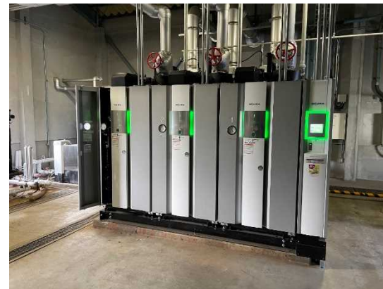
蒸気ボイラ (都市ガス) (設備本体)
