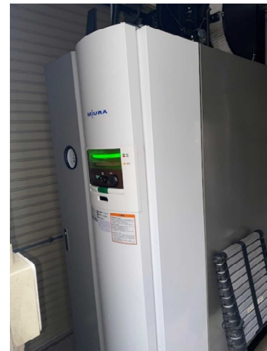
ガス焚ボイラ
