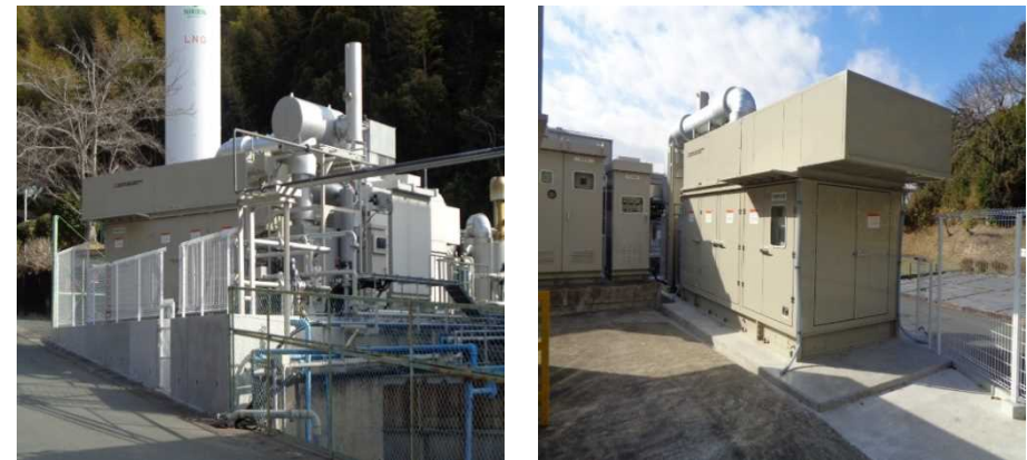
コージェネレーション設備
