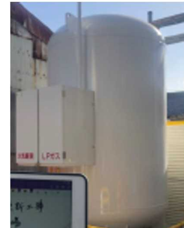
蒸気ボイラ用燃料 (LPGタンク) 155
