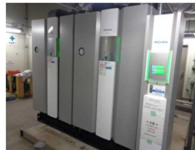
蒸気ボイラ (LNG)
