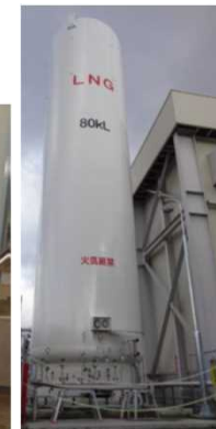
LNGサテライト
