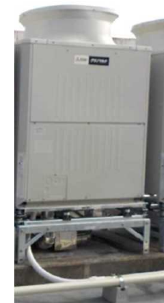
高効率空調機 (室外機)
