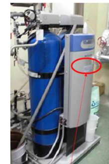
ドレン回収設備
