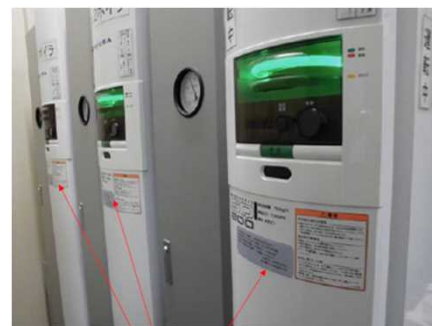
蒸気ボイラ設備
