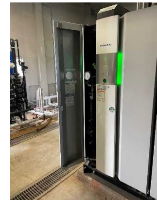
蒸気ボイラ (都市ガス) (設備内部)
