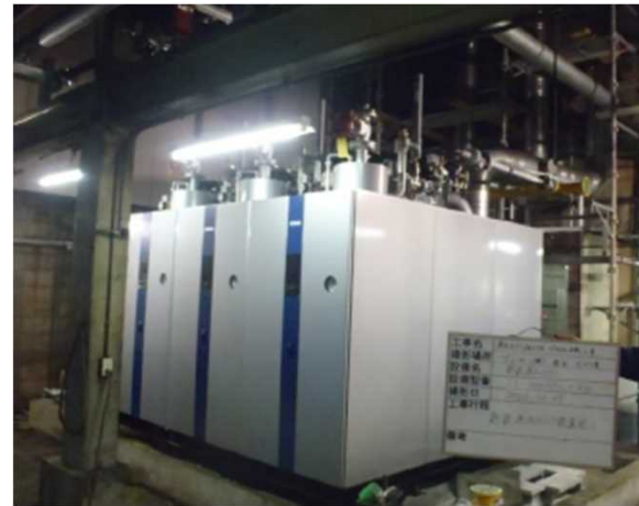
蒸気ボイラ (LPG) (設備本体)
