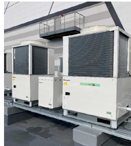
冷凍機ユニット
