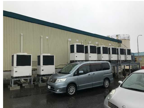
冷凍機ユニット
