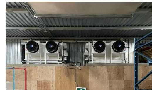
ガスクーラー (冷凍庫内部)
