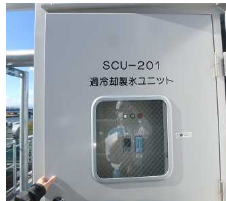
過冷却製氷式氷蓄熱システム
