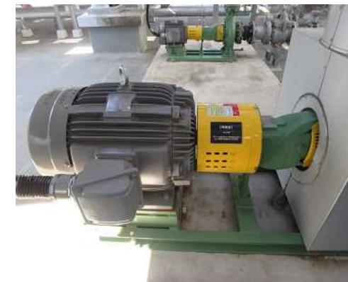
過冷却水ポンプ
