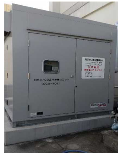
冷凍機ユニット
