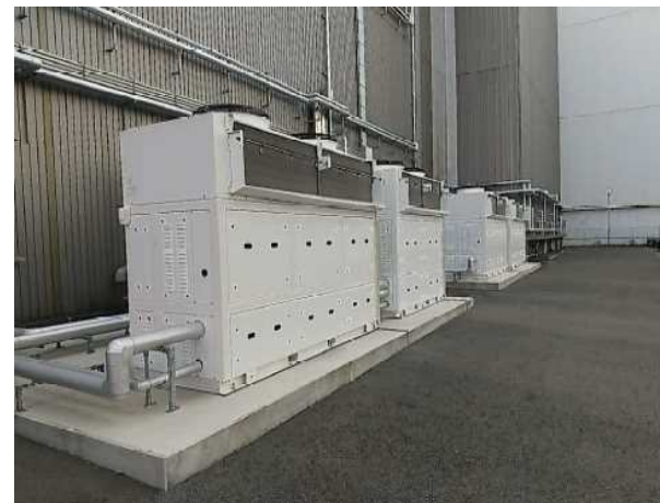
冷凍機ユニット
