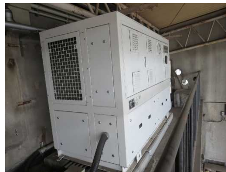
冷凍機ユニット (冷凍庫外部)
