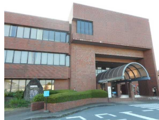
対象施設（大穂庁舎）の外観
