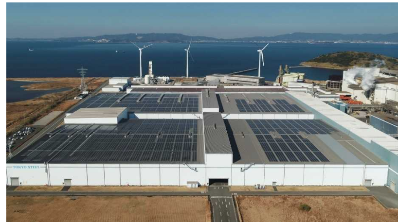
田原工場 製品倉庫棟屋根上の導入設備(太陽光パネル)
