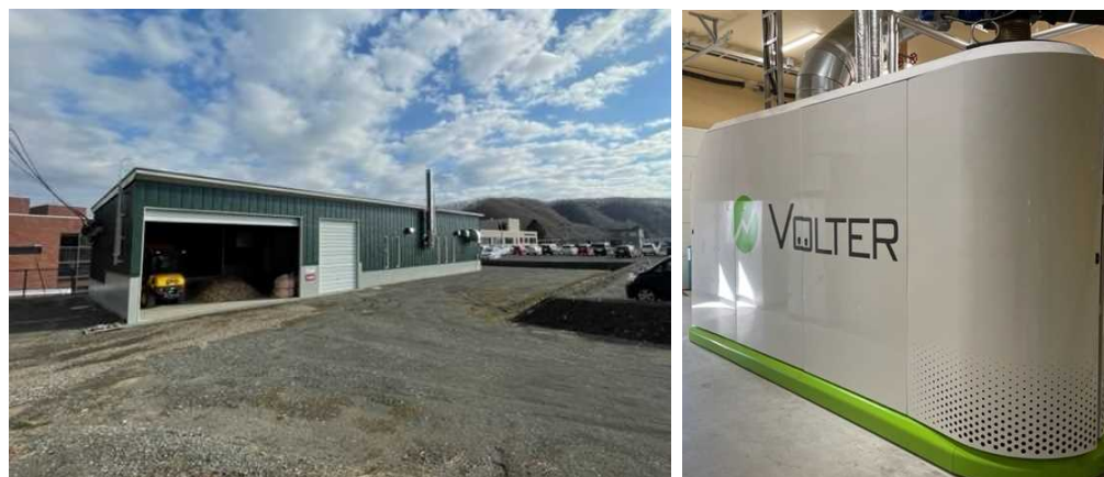
左：対象施設（平取町木質バイオマスセンター）の外観 右：導入設備（熱電併給機）
