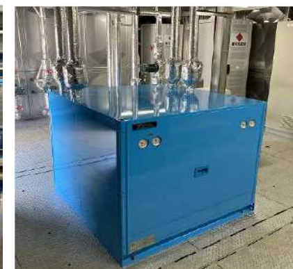
海水淡水化熱源給湯ヒートポンプ
