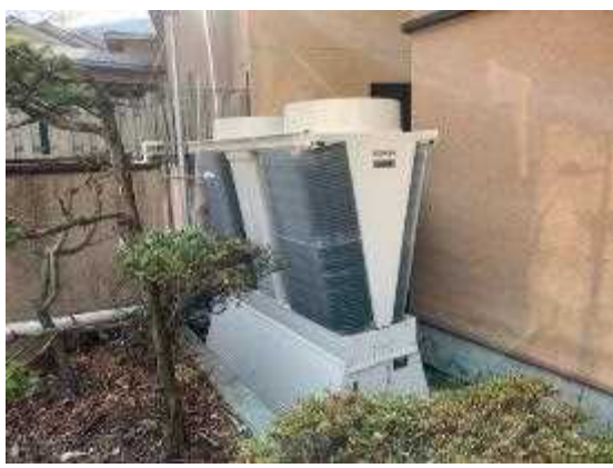
循環加温ヒートポンプ
