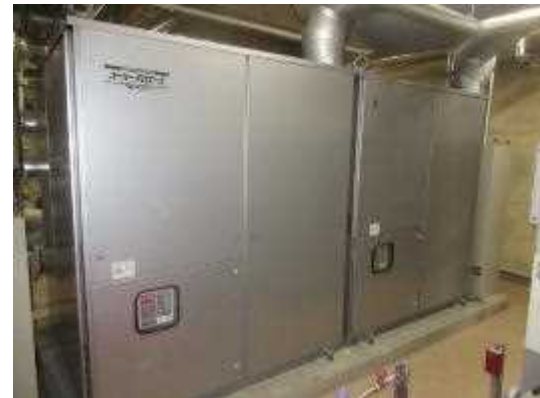
冷温水発生器
