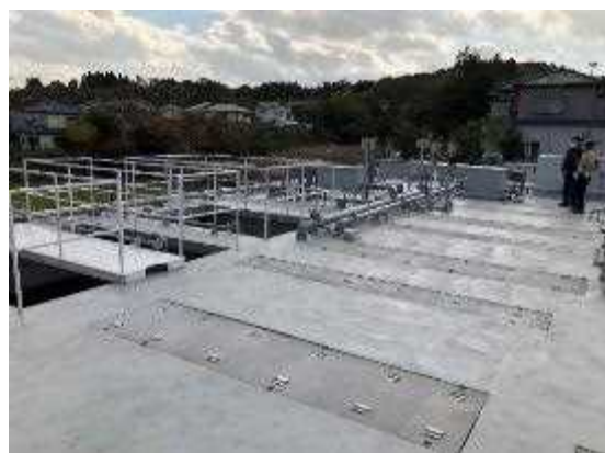
浄化槽システム (全体)
