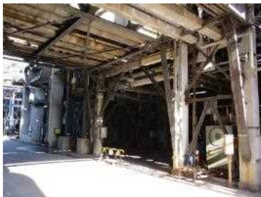
LED照明 (全体)
