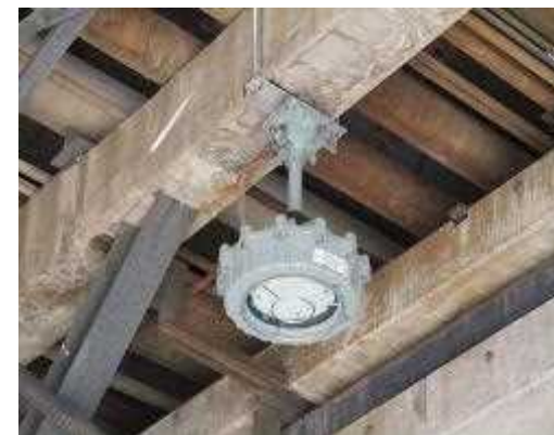
LED照明 (設備本体)
