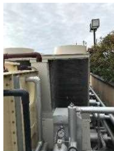
ヒートポンプ熱源設備
