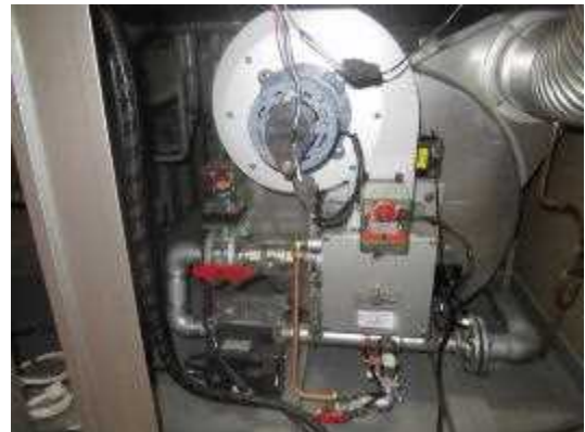
ガスバーナー配管
