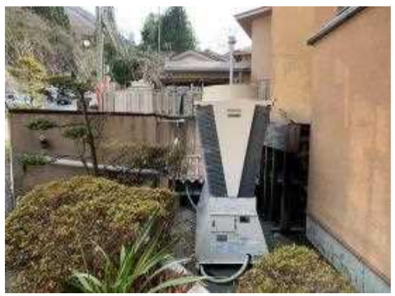
循環加温ヒートポンプ
