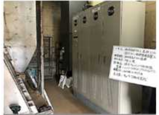
誘引ファンインバータ制御盤
