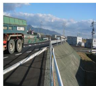
路盤材施工事例
