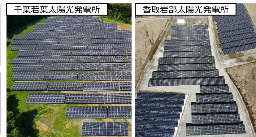
図 太陽光発電所の写真
