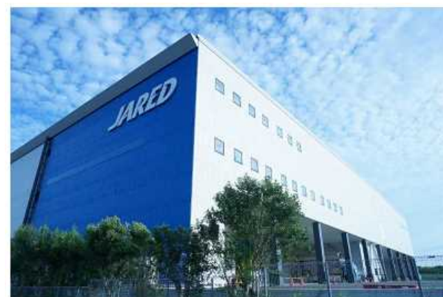
図 太陽光発電設備を設置したSMS JARED大井川センター
