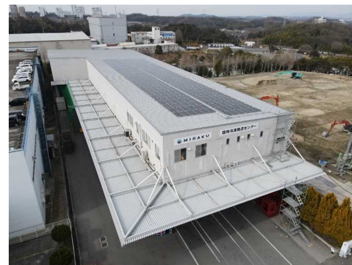
図 太陽光発電設備の写真
