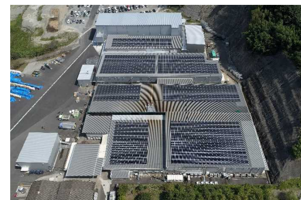
図 太陽光発電設備の写真
