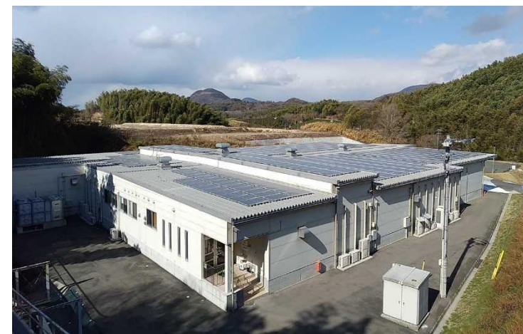
図 太陽光発電導入後の写真
