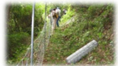
シカ防護柵の設置
