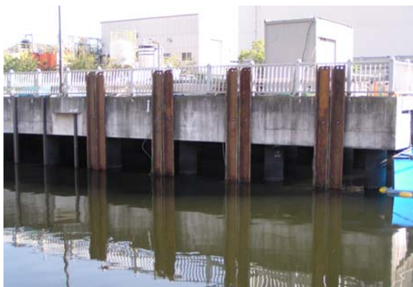
エコシステム護岸実証実験
