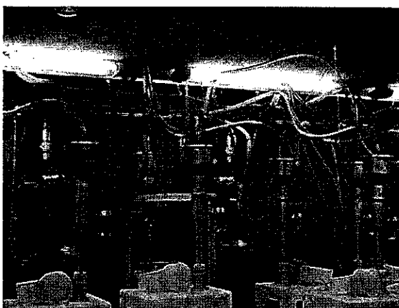
図3 集合配管から分粒装置への配管
