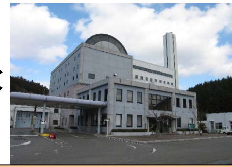
脊振広域クリーンセンター 処理能力 74t/日
