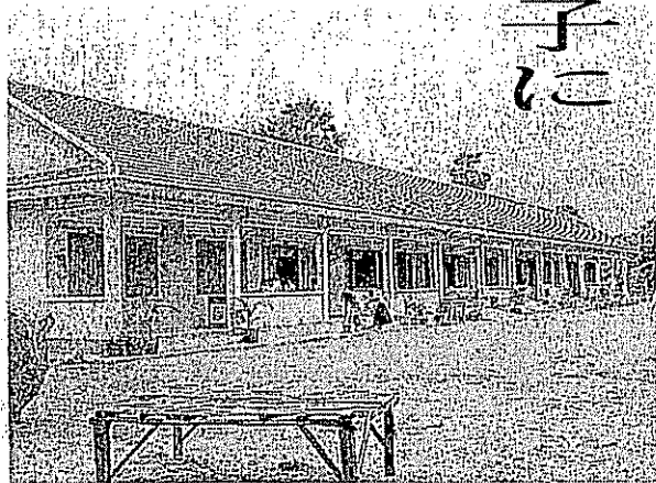
完成したトレア小学校の新校舎
