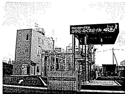
図9 廃食用油燃料化プラント (製造能力 5,000 ℓ/日, 16年6月竣工)
