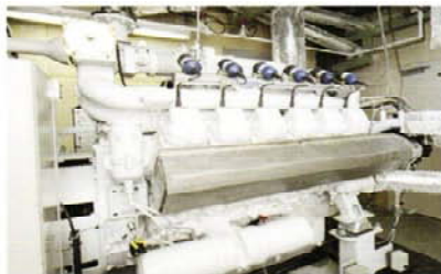
ガスエンジン
