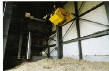
チップヤード&クレーン
