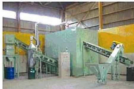
■ 使用済み乾電池処理設備
