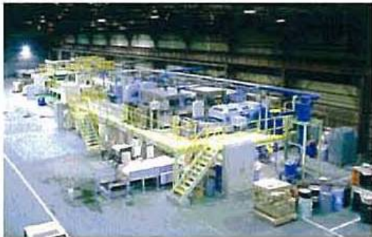
横浜蛍光灯リサイクル工場
