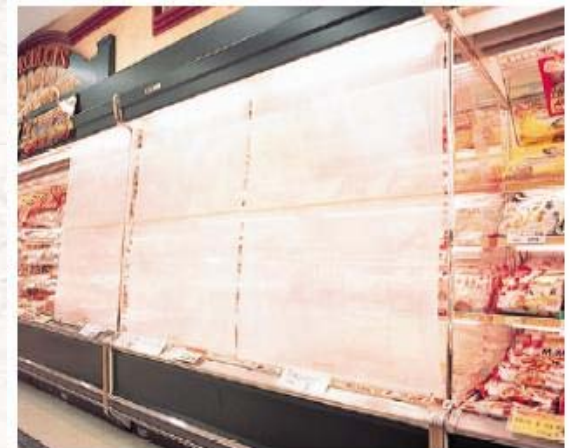
冷蔵機器のナイトシャッター (冷気の漏れを防ぎます)
