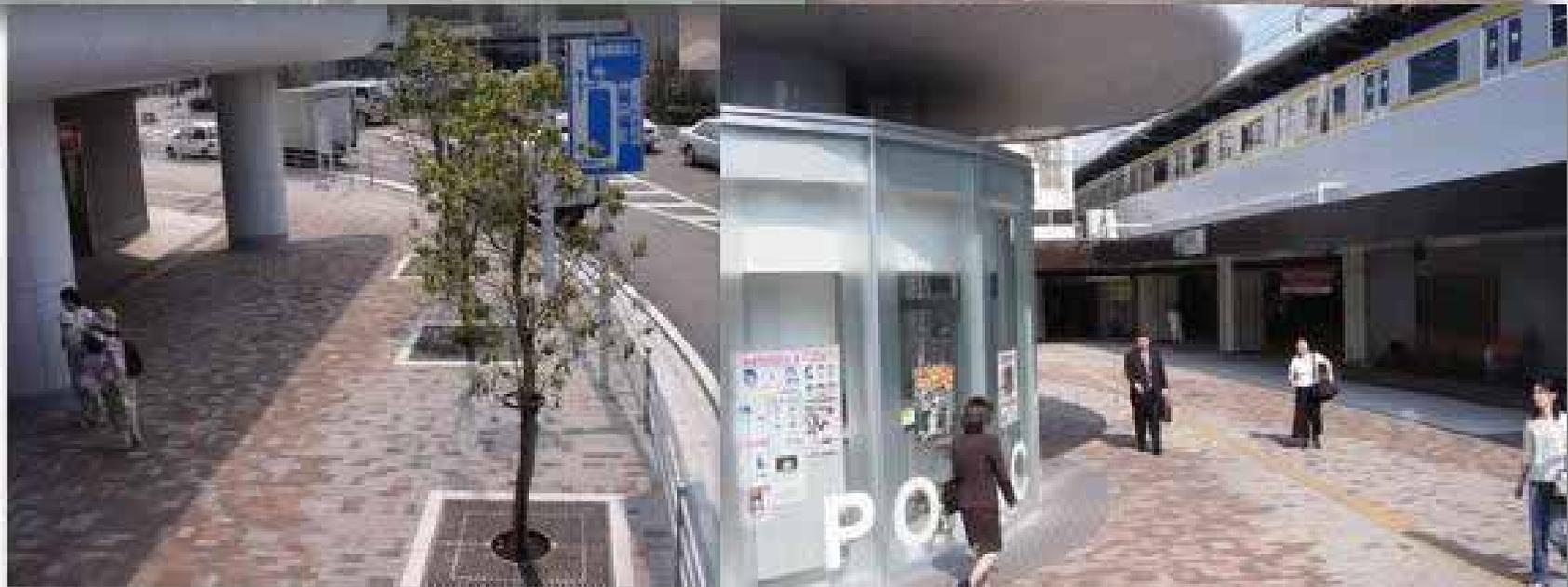
骨材から生産された透水ブロックを使用した施工例
