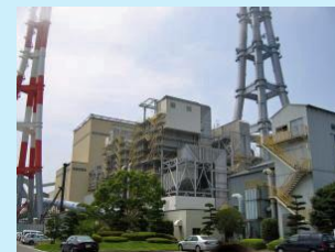
常磐共同火力発電所発電施設
