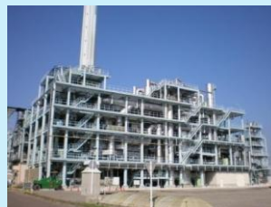
汚泥炭化施設
